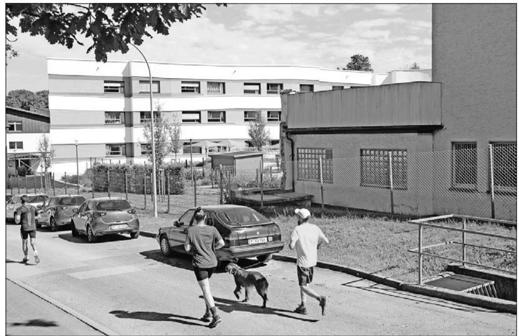
Der Neubau Suchtklinik soll angrenzend an das neue „Haus Feldberg“ entstehen. Das alte „Haus Sonne“ (im Ansatz rechts erkennbar) wird dafür abgerissen. Foto: js
